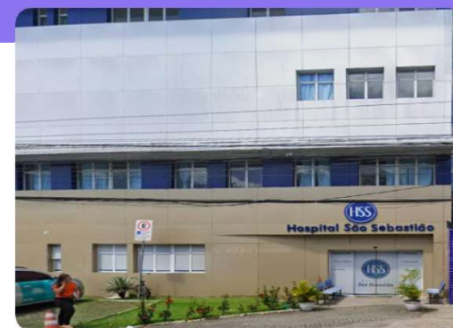
Hospital São Sebastião CABO – PE
