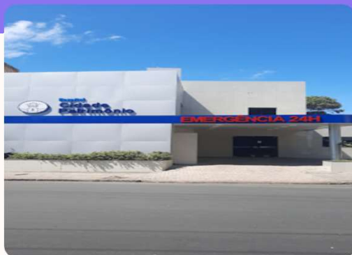
Hospital Cidade Patrimônio OLINDA – PE
