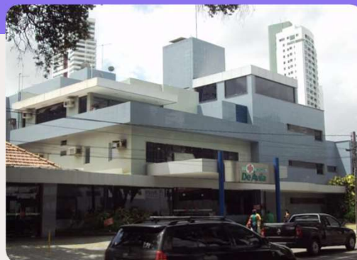
Hospital De Ávila RECIFE – PE
