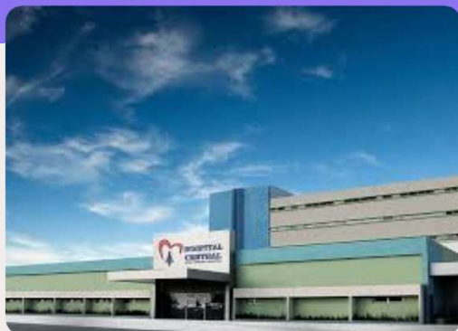
Hospital Central Nossa Senhora Aparecida PAULISTA – PE
